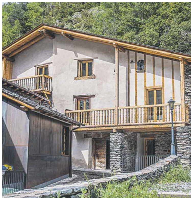
La façana principal conserva la balconada i les finestres originals.
