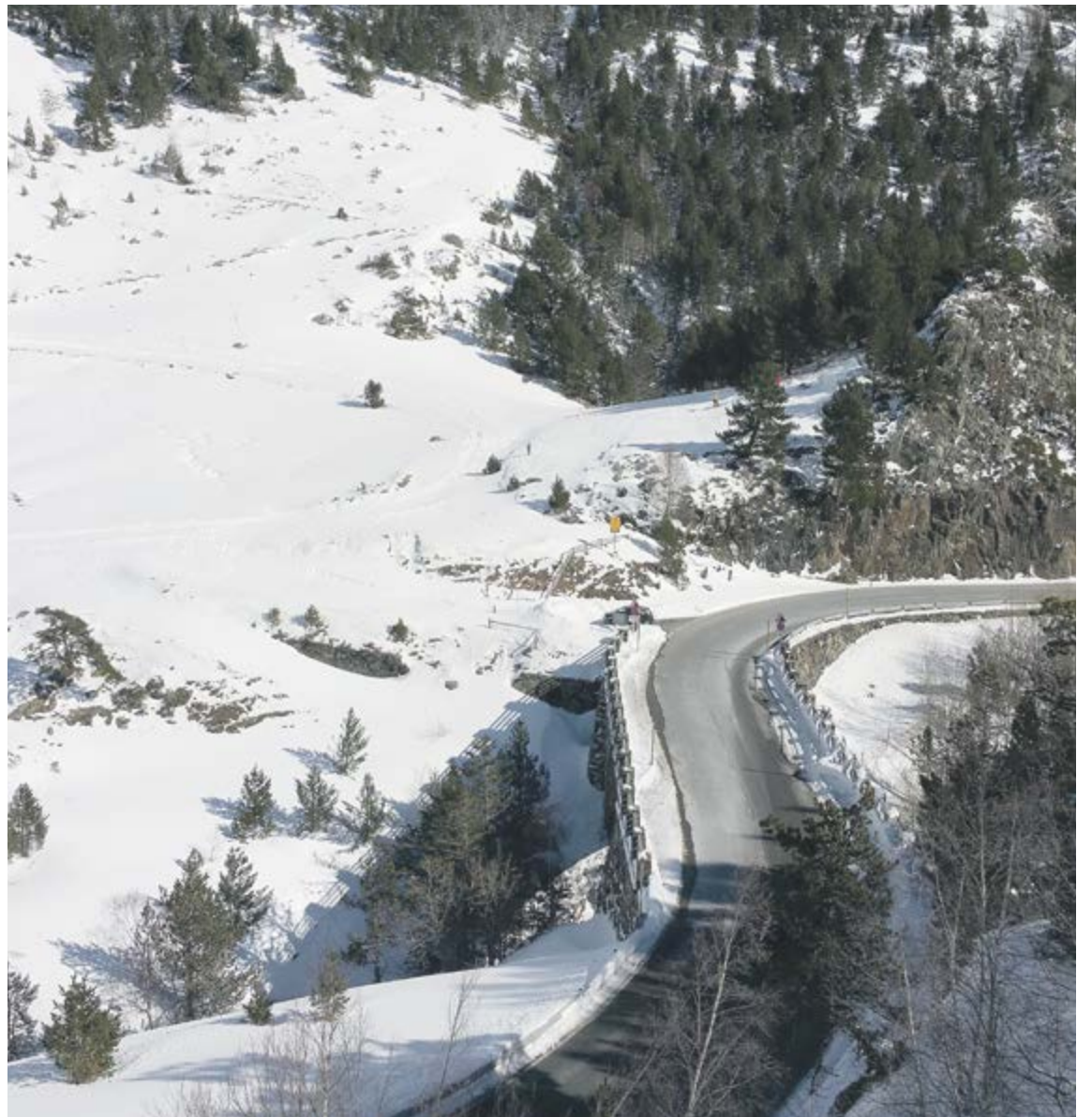
Panoràmica del pont del Castellar, on es construirà la minicentral hidroelèctrica. FOTO: CARLES MÚGICA
