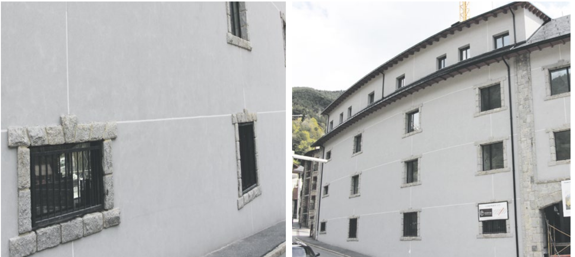
Detall de l'arquitectura del granit a les finestres de l'edifici, bé d'interès cultural. A la dreta, la façana conservada de les Escoles Velles.
