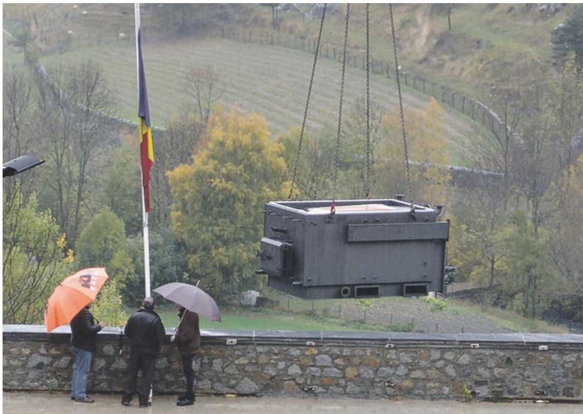
Moment de la instal·lació de la caldera de biomassa al CEO.
