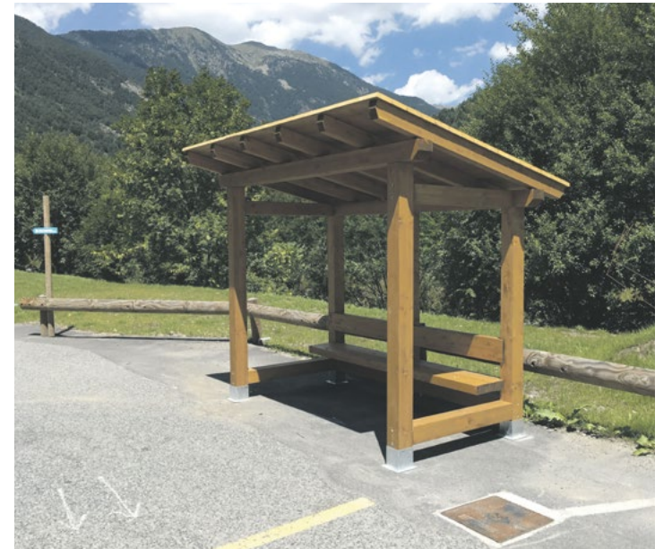
Marquesina a Sornàs, pendent de col·locació definitiva.
