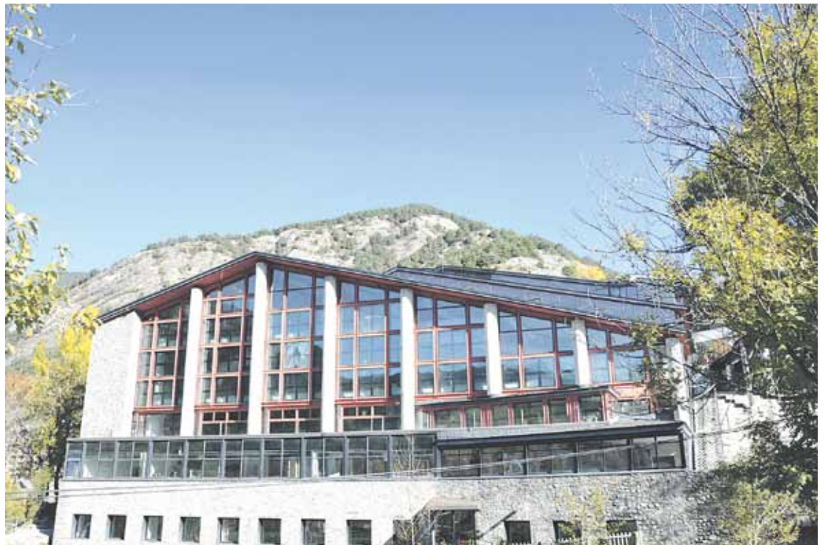
Una perspectiva de la façana del Centre Esportiu d'Ordino.
