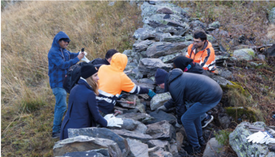
Tècnics treballant al mur de pedra seca de Sorteny.
